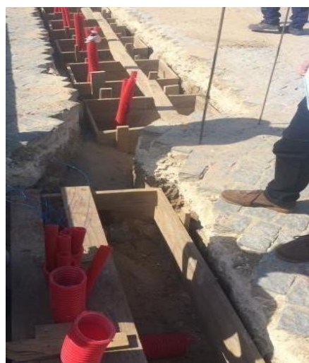
Figura 28 - Cofragem para a sapata do Totem com posicionamento de negativos
