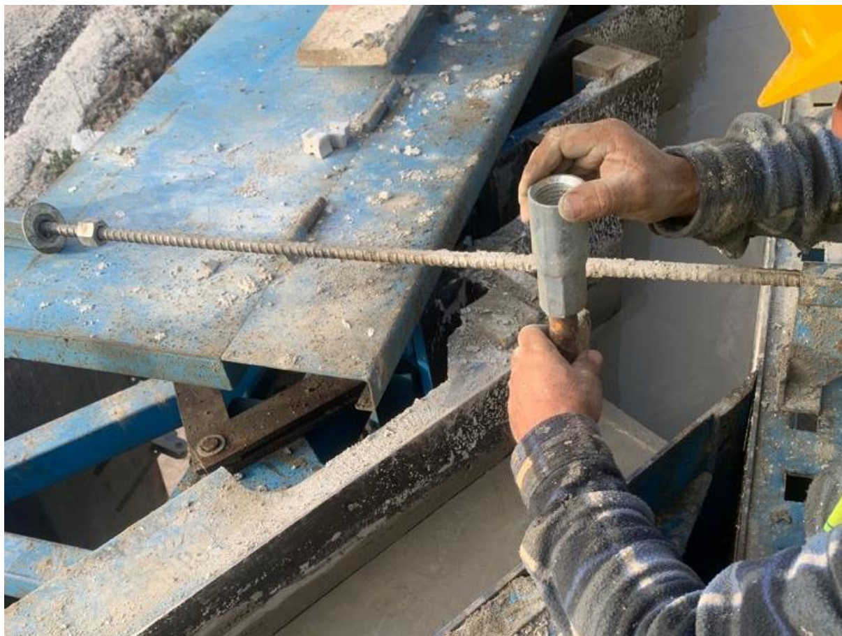
Figura 4.11- Colocação das ancoragens que, mais tarde, permitem retirar a Escada da máquina, com recurso a grua.
