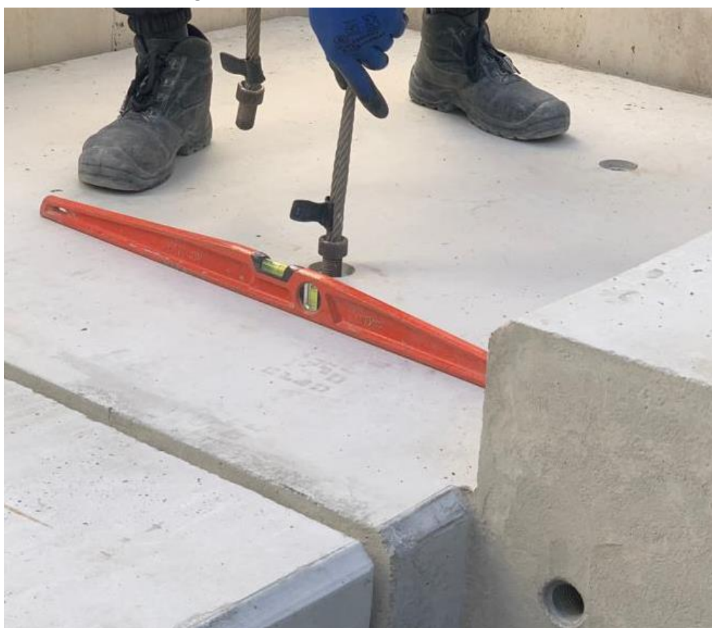
Figura 4.15- Verificação da horizontalidade da Escada e remoção das ancoragens.
