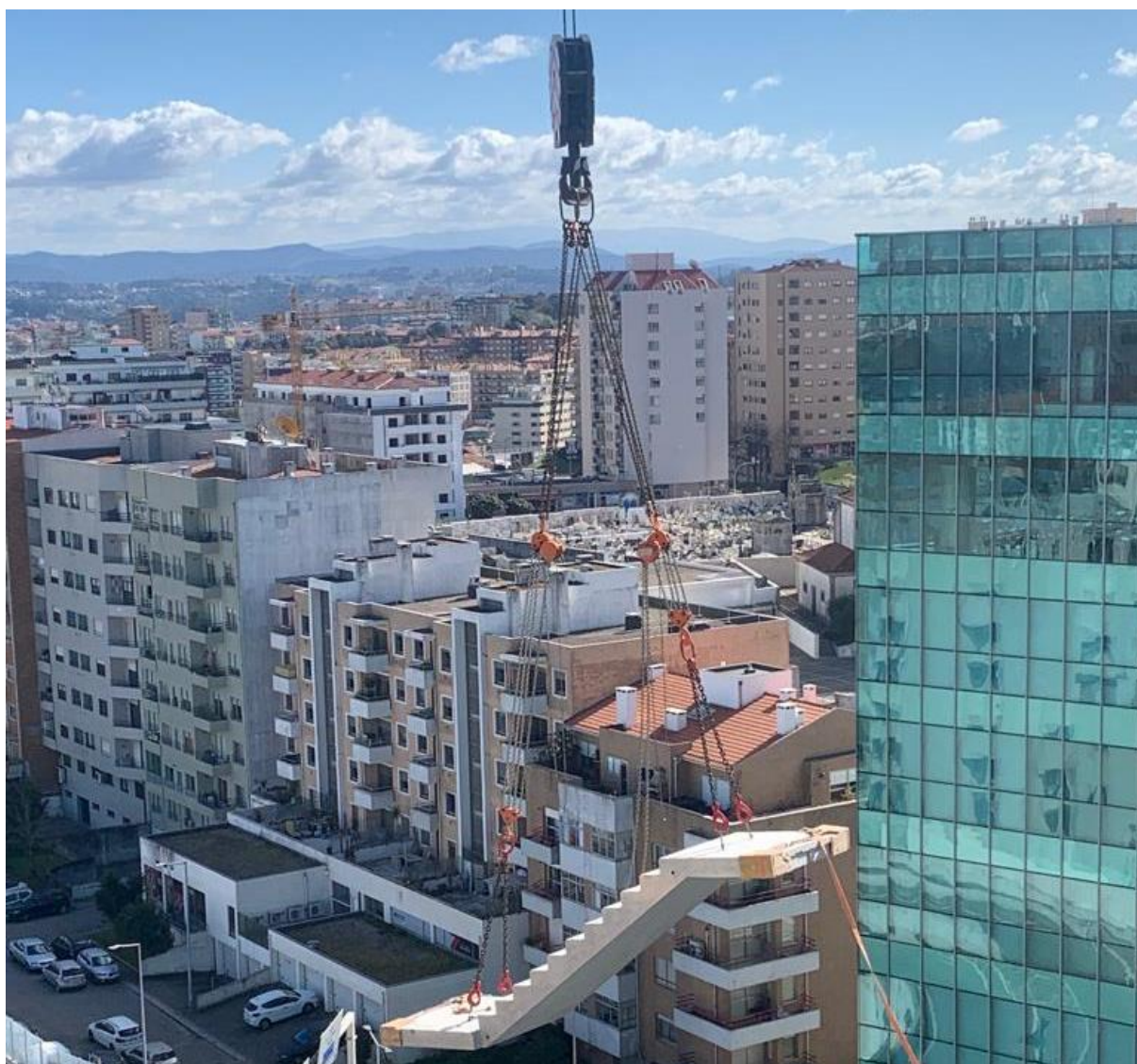
Figura 4.14- Levantamento das Escadas Pré-fabricadas com recurso a auto-grua.
