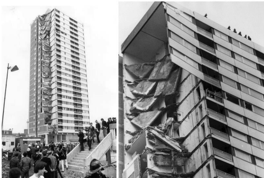
Figura 2.2- Edifício Ronan Point, construído com materiais pré-fabricados, 1968 [15].
