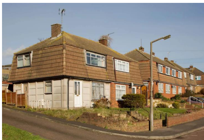
Figura 2.1- "The Cornish Units", casas construídas com painéis de betão pré-fabricado [13].
