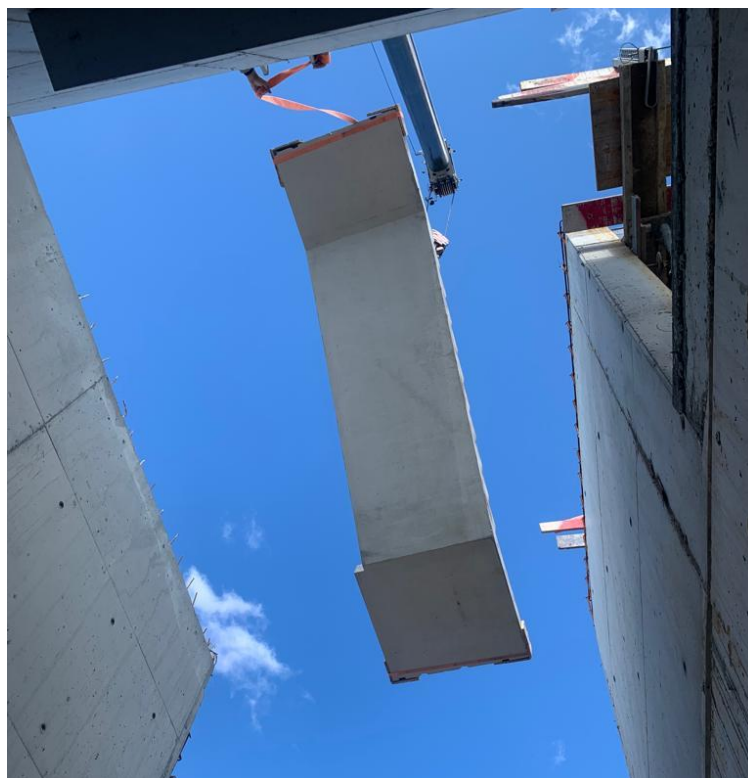
Figura 6.1- Colocação das Escadas Pré-fabricadas no núcleo de escadas.
