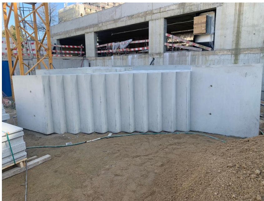
Figura 2.33- Escadas Pré-fabricadas com recurso a máquina industrial, 2023.
