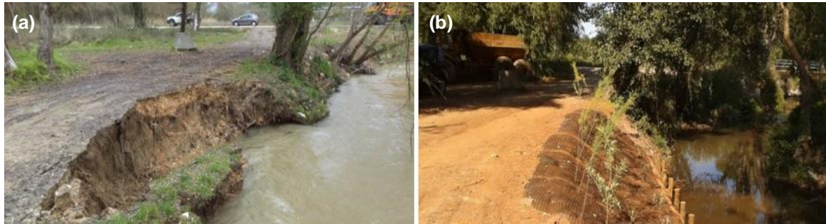
Figura 4.7 - Aspeto geral do trecho da ribeira intervencionado: (a) antes da obra; (b) depois da obra (Interação, 2013)
