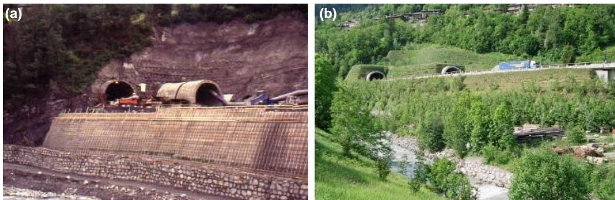
Figura 3.22 - Aplicação de terra reforçada em talude de autoestrada, Itália: (a) aspeto durante a construção; (b) aspeto passados 18 anos (Cornelini & Sauli, 2012)
