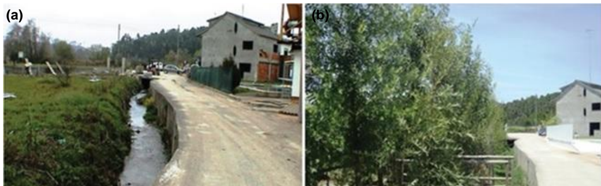
Figura 4.4 - Aspeto geral do trecho da ribeira intervencionado: (a) antes da obra; (b) depois da obra (Interaço, 2013)
