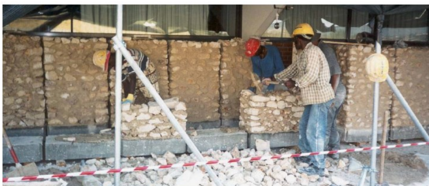
Figura 4. 3 - Construção dos modelos experimentais (Pinho, 2007).
