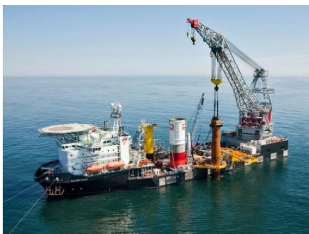
Figura 2.16 - Instalação de uma mono-estaca [47].
