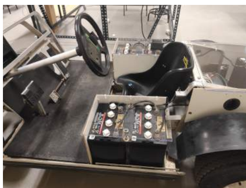
Figura 5.12: Proteções das baterias que estão nas laterais do assento do piloto.
