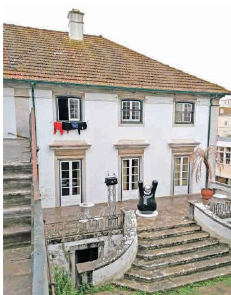
FIGURA 4 · Fachada da entrada para a Sala da Academia. Fotografia da autora.
