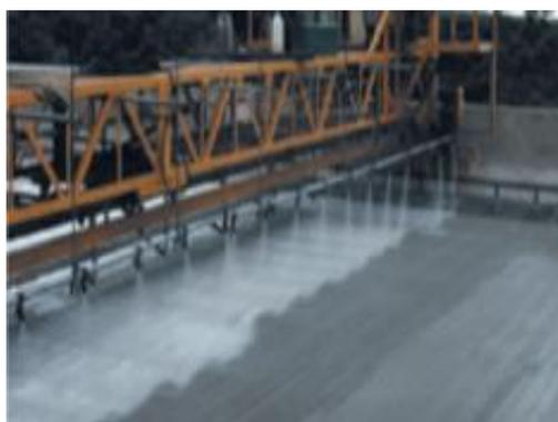
Figura 2.15 - Sistema mecânico de película para a cura do betão, redução da fissuração- (BASF, 2021)
