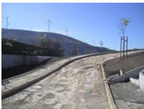
Figura 2.5 - Base de pavimento em A.G.E compactada com cilindro - Bucelas
