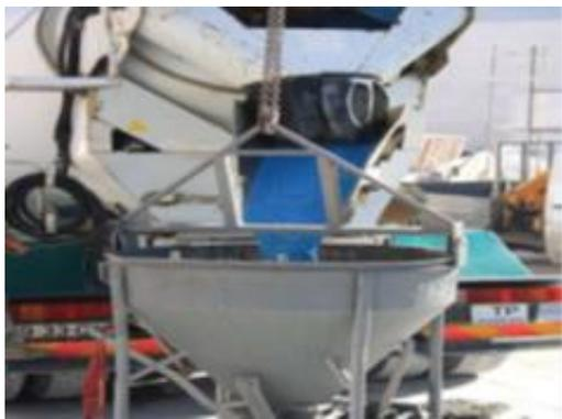
Figura 2.8 - Camião de transporte descarga para balde, transportado por grua até ao local de aplicação (Concremix, 2021)
