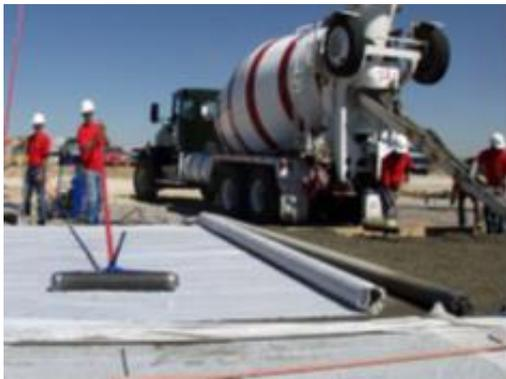
Figura 2.18 - Aplicação de tela para controlo de humidade, (CRMCA, 2021)
