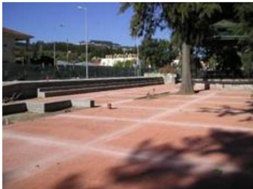
Figura.2.20 - Esquarteamento após presa, para criar juntas de dilatação executada com máquina de disco - Loures
