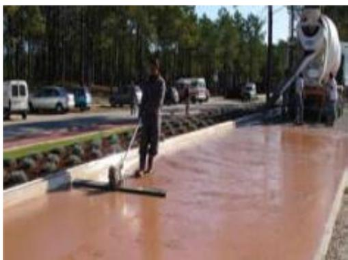
Figura 2.12 - Acabamento com talocha mecânica, liso - (Infociments, 2021)
