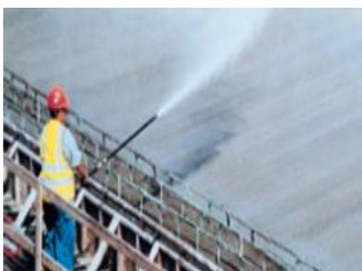
Figura 2.16 - Controlo da humidade no betão através da introdução de água (BASF, 2021)
