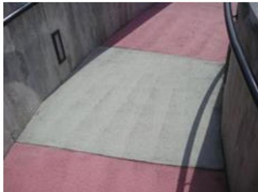
Figura 2.21 - Junta de betonagem com diferentes cores - Bucelas
