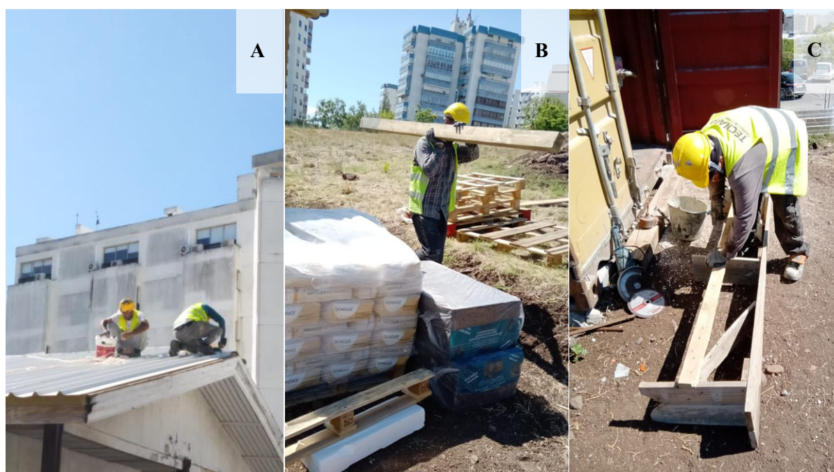
Figura 5.3 Exemplos de trabalhos sujeito a constrangimento físico: trabalhadores agachados sobre cobertura (A); movimentação manual de carga (B); postura inclinada durante montagens (C).
