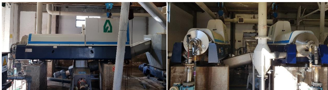
Figura 3.5 - Centrífugas da ETAR de Chelas (D4L).
