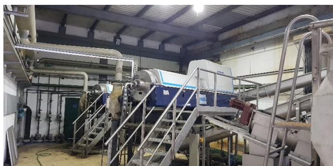
Figura 3.8 - Centrífugas da ETAR de Frielas (D5L).
