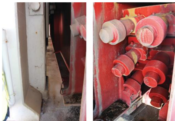
Figura 4.18 - Ponte Edgar Cardoso. Ancoragem do atual tirante 1 no tabuleiro (pilar de transição P7)
