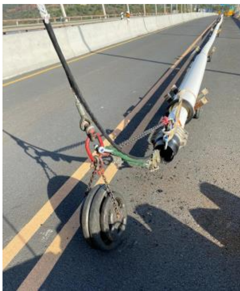
Figura 4.49 - Ponte Internacional do Guadiana. Início do içamento do tudo de revestimento
