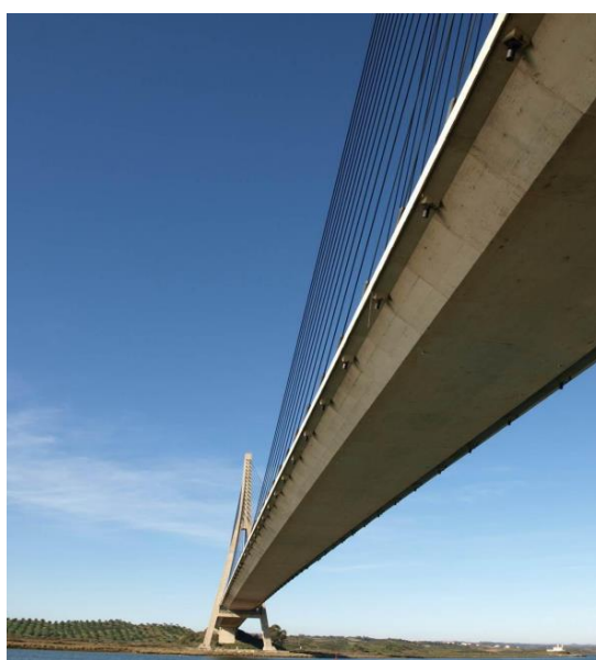
Figura 4.31 - Ponte Internacional do Guadiana. Vista inferior do tabuleiro
