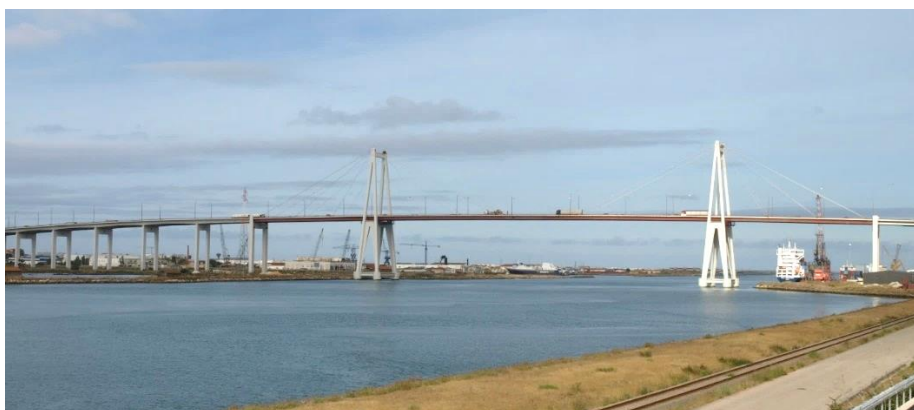
Figura 4.1 - Ponte Edgar Cardoso. Vista geral
