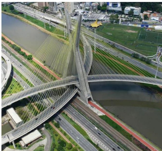
Figura 2.42 - Ponte Octávio Frias de Oliveira - Brasil, 2008
