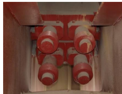
Figura 4.7 - Ponte Edgar Cardoso. Ancoragens inferiores dos tirantes nas vigas principais
