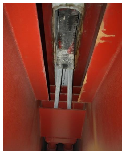
Figura 4.20 - Ponte Edgar Cardoso. Ancoragem do atual tirante 6 no tabuleiro
