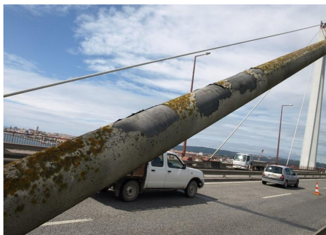
Figura 3.43 - Destaque do revestimento do enrolamento de proteção dos tirantes
