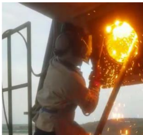
Figura 4.45 - Ponte Internacional do Gadiana. trabalhos para aumento do diâmetro no tubo da ancoragem no tabuleiro
