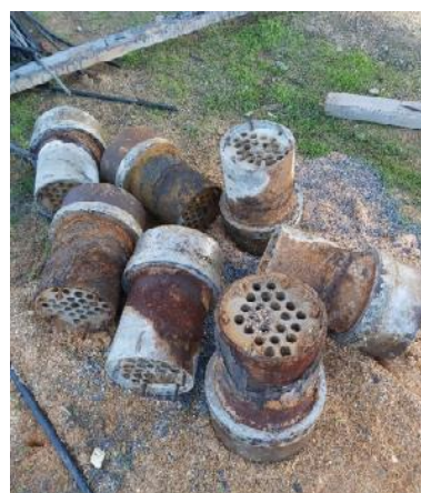
Figura 4.44 - Ponte Internacional do Guadiana. Ancoragens de tirante no tabuleiro após a remoção
