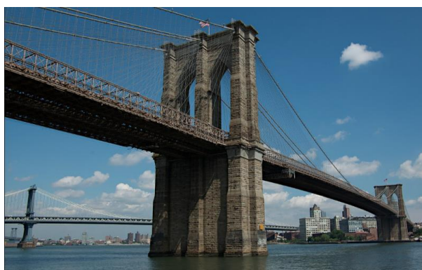
Figura 2.36 - Ponte de Brooklyn em Nova Iorque, 1883, com tabuleiro híbrido (suspensão e atirantado)
