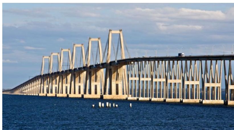
Figura 2.29 - Ponte Maracaibo, Venezuela, 1962, um dos primeiros exemplos de ponte de tirantes com tabuleiro de betão armado
