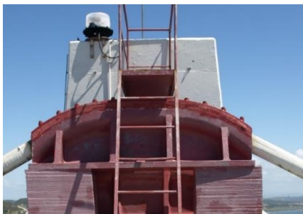
Figura 4.6 - Ponte Edgar Cardoso. Selas de desvio dos tirantes no topo das torres
