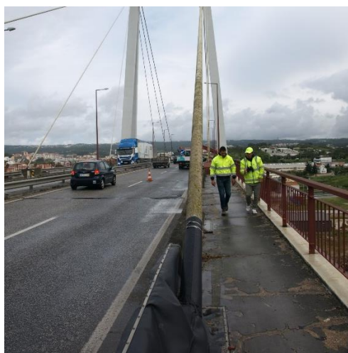
Figura 4.19 - Ponte Edgar Cardoso. Inserção do atual tirante 6, ao nível do tabuleiro
