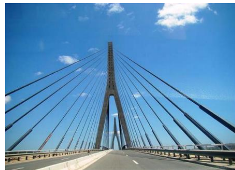
Figura 2.26 - Ponte internacional sobre o rio Guadiana, com torre em forma de Y invertido
