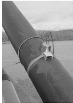
Figura 3.18 - Fixação através de uma chapa metálica e braçadeiras
