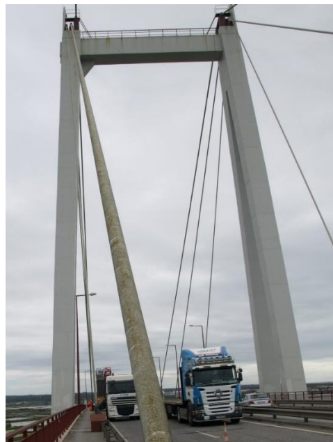
Figura 4.5 - Ponte Edgar Cardoso. Vista da torre sul (Fonte: LNEC)
