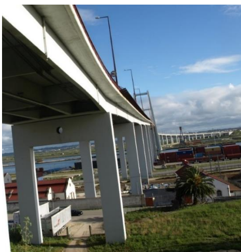
Figura 4.8 - Ponte Edgar Cardoso. Vista geral do viaduto de acesso norte
