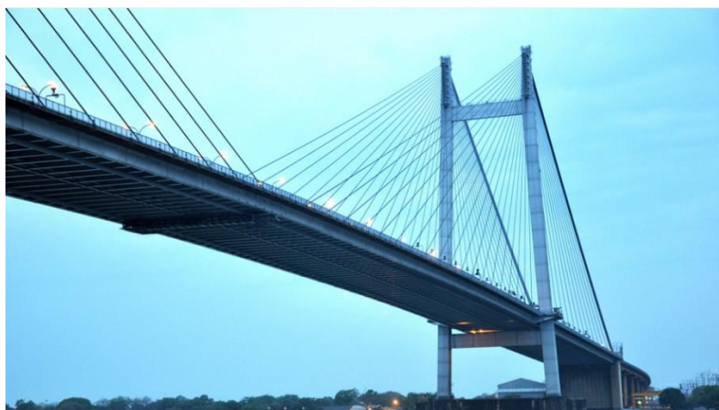
Figura 2.30 - Ponte sobre o rio Hoogly, Calcutta 1992, com tabuleiro misto aço-betão
