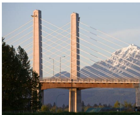
Figura 2.23 - Ponte Golden Ears, Canadá, formada por dois pilares verticais
