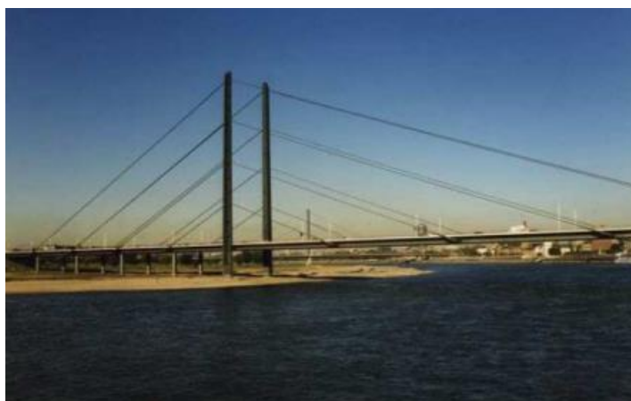
Figura 2.9 - Ponte Knee, Alemanha, com tirantes dispostos em harpa
