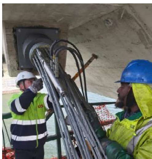
Figura 4.51 - Ponte Internacional do Guadiana. Tensionamento dos cabos com o sistema ConTen
