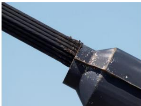
Figura 3.41 - Exemplo da inexistência ou ineficácia de dispositivos de centragem dos cabos
