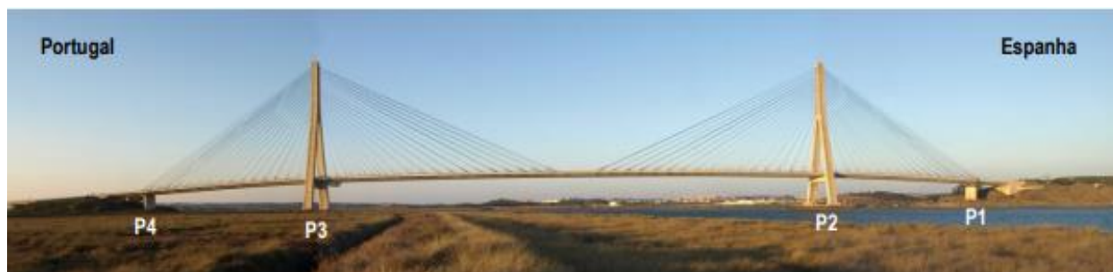
Figura 4.30 - Ponte Internacional do Guadiana. Vista geral de jusante
