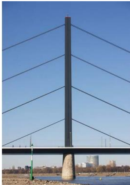
Figura 2.22 - Ponte Oberkassel, Dusseldorf, com torre em fuste único
