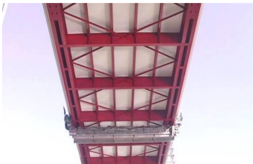
Figura 4.3 - Ponte Edgar Cardoso. Vista inferior do tabuleiro
