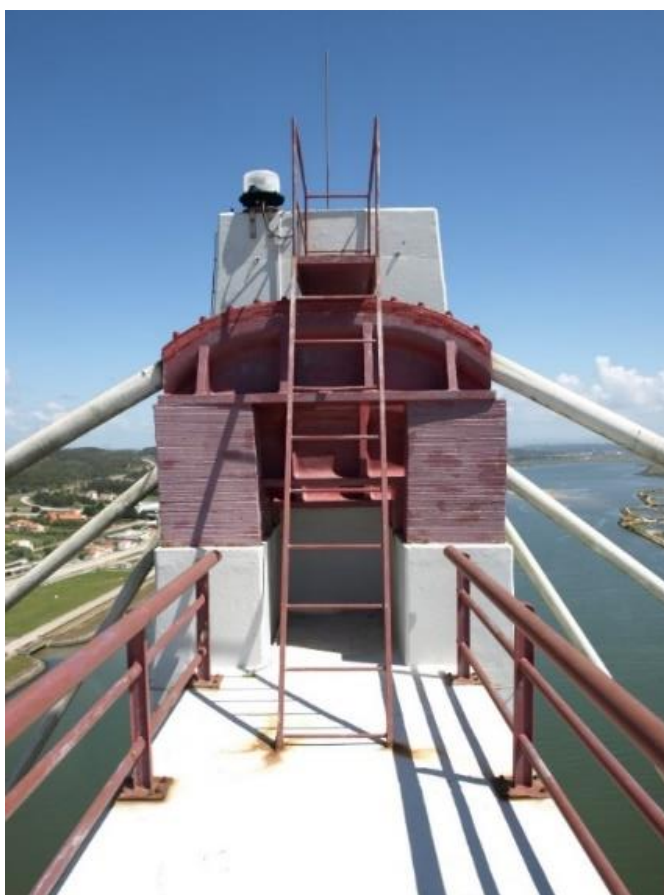
Figura 4.17 - Ponte Edgar Cardoso. Sela de desvio atual no topo da torre norte (montante)
