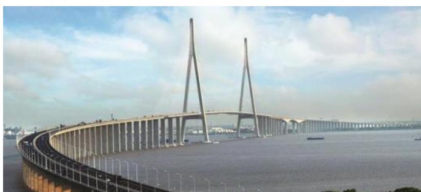
Figura 2.41 - Ponte Sutong Yangtze - China, 2008
