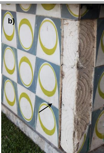
Empolamento e destacamento de vidro sem chacota aderente.
