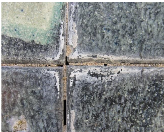
Figura 1.22 Eflorescências nas juntas dos azulejos
