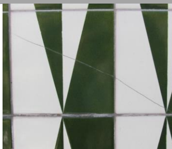
Rutura e destacamento de vidro.
