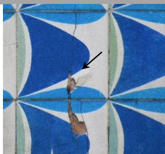
Empolamento e destacamento de vidroado.
