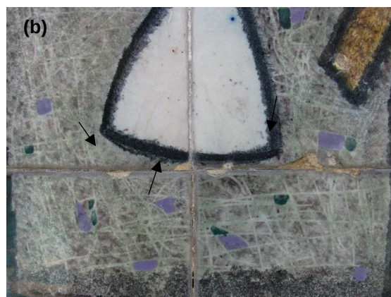
Figura 1.5 a) lacuna com presença de colonização e falta de chacota (2 cantos); b) falhas de vidrado nas arestas
