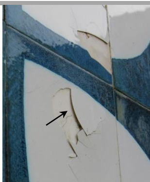
Empolamento e frente de destacamento do vidrado branco.
