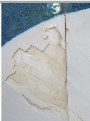
A perda de vidrado parece ocorrer primeiramente no vidrado branco, geralmente de forma limpa (sem chacota aderente).
