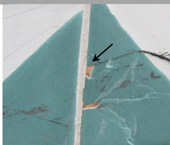
Destacamento de vidro
