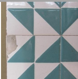
Empolamento e destacamento do vidro.
