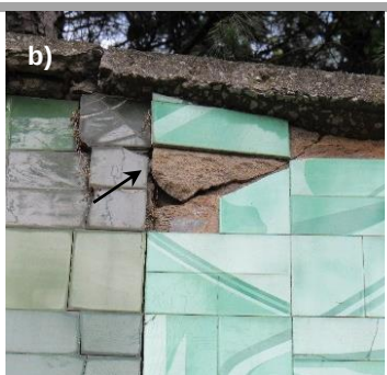
Ausência de azulejos (a) com empolamento em certas zonas (b) e presença de argamassa de assentamento após a queda d azulejos (c) .
