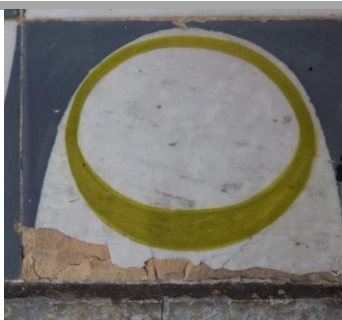
Não existe um padrão para a perda de vidro, parecendo ocorrer em qualquer local de maior fragilidade e por vezes, ocorre de forma limpa (sem chacota aderente).
