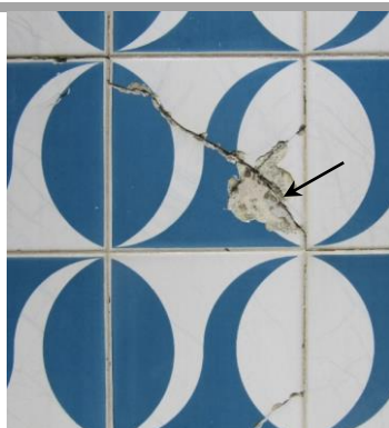
A perda de vidrado parece ocorrer primeiramente no vidrado branco e de forma limpa (sem chacota aderente), contornando o vidrado azul sem o destacar.
