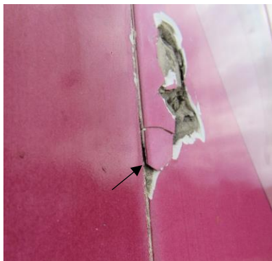
Destacamento de vidrado
