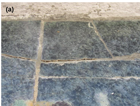
Figura 1.21 Fratura dos azulejos na zona superior do painel. Dano provocado muito provavelmente devido a problemas estruturais do muro
