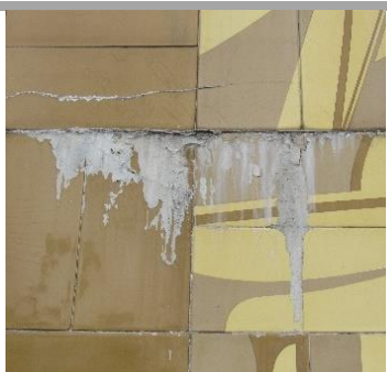
Ausência de azulejos (a) com empolamento em certas zonas (b) e presença de argamassa de assentamento após a queda d azulejos (c) .
