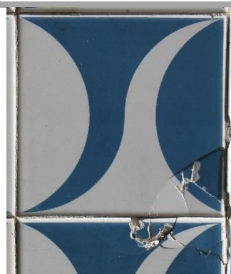
A perda de vidrado parece ocorrer primeiramente no vidrado branco e de forma limpa (sem chacota aderente), contornando o vidrado azul sem o destacar.
