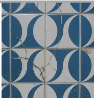
Fratura com perda de vidrado.
