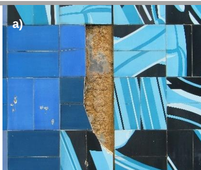
Ausência de azulejos (a) com empolamento em certas zonas (b) e presença de argamassa de assentamento após a queda d azulejos (c) .
