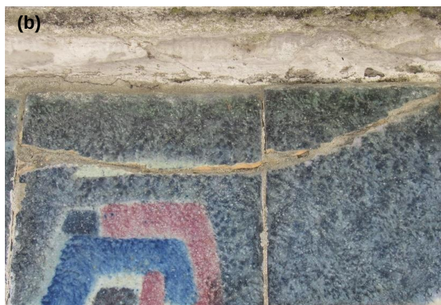
Figura 1.21 Fratura dos azulejos na zona superior do painel. Dano provocado muito provavelmente devido a problemas estruturais do muro
