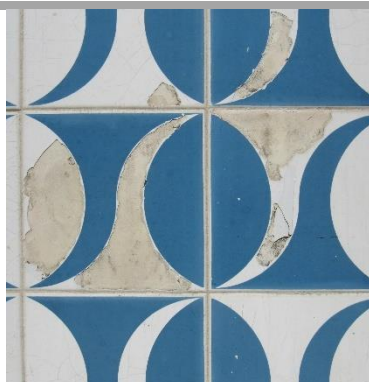
Fratura com perda de vidrado.
