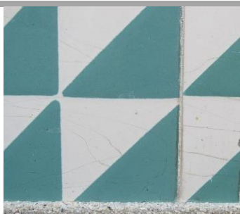
Fissuras de vidrado.
