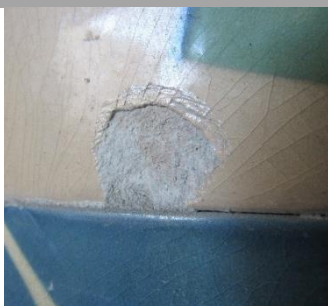
Fissuração do vidro.
