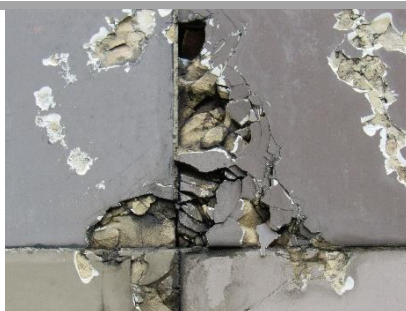
Destacamento de vidrado e fratura da chacota. Frente de destacamento de vidrado (linha no vidrado)
