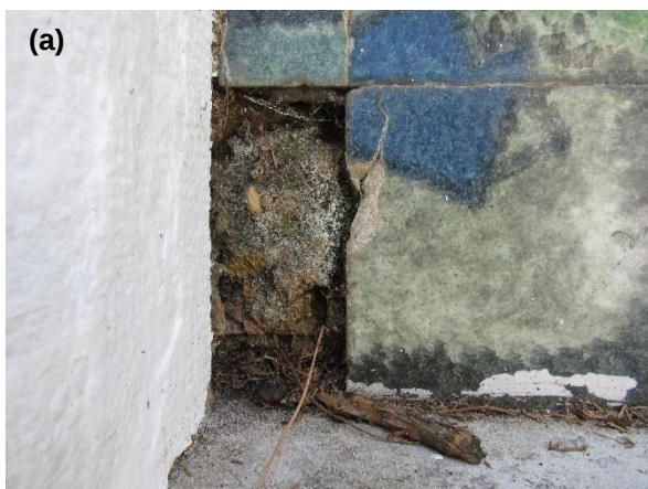
Figura 1.3 a) inexistência de um azulejo; b) azulejo fissurado e falhas de vidrado
