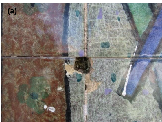
Figura 1.5 a) lacuna com presença de colonização e falta de chacota (2 cantos); b) falhas de vidrado nas arestas
