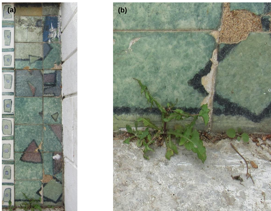
Figura 1.31 a) Painel 9 situado no lado direito do meio arco; b) presença de plantas na zona inferior
