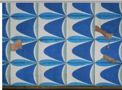
Empolamento e destacamento de vidroado.
