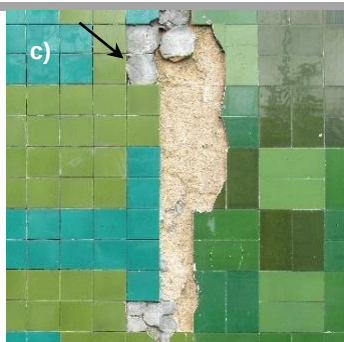
Ausência de azulejos (a) com empolamento em certas zonas (b) e presença de argamassa de assentamento após a queda d azulejos (c) .
