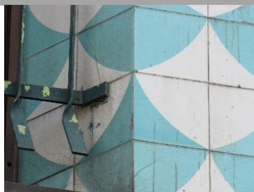
Fissuras de vidro.
