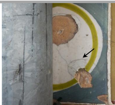
Empolamento e destacamento de vidro sem chacota aderente.
