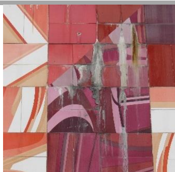
Ausência de azulejos (a) com empolamento em certas zonas (b) e presença de argamassa de assentamento após a queda d azulejos (c) .
