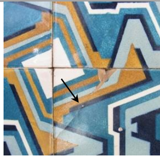
Destacamento e perda de vidrado sem chacota aderente.
