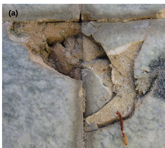
Figura 1.15 a) lacuna e multi-fragmentação da chacota e vidro; b) desalinhamento dos azulejos e juntas sem preenchimento, o que pode ter conduzido à fratura de vidro
