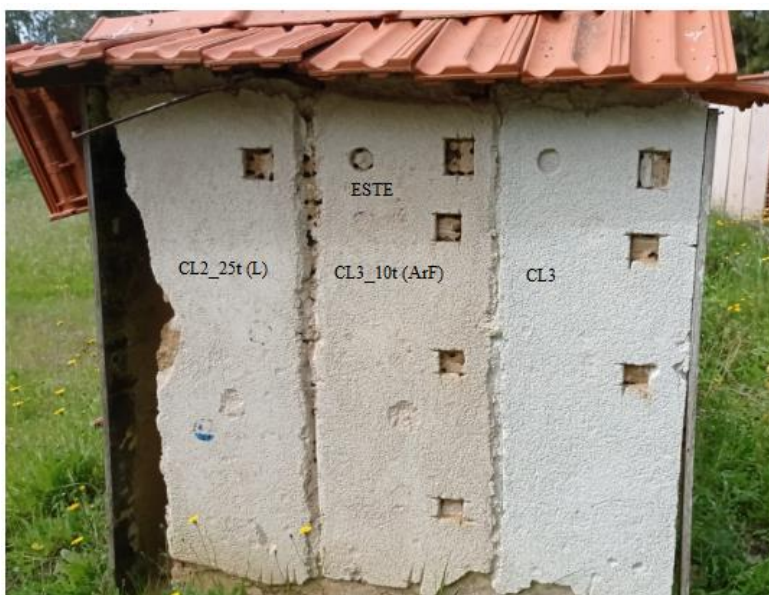
Figura 5.4 - Inspeção visual no Murete 4 com rebocos de cal aérea e terra
