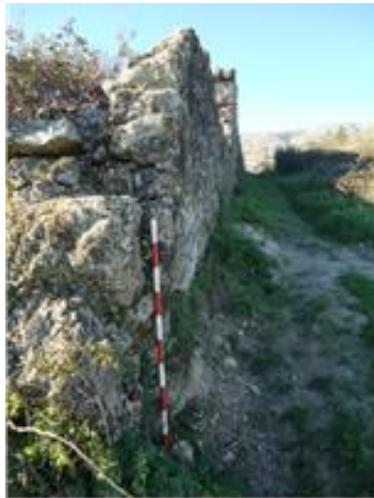
**Figura E:** Muro de contenção das râmolas (fotografia de Rodrigo Dias. 17/3/2021).
