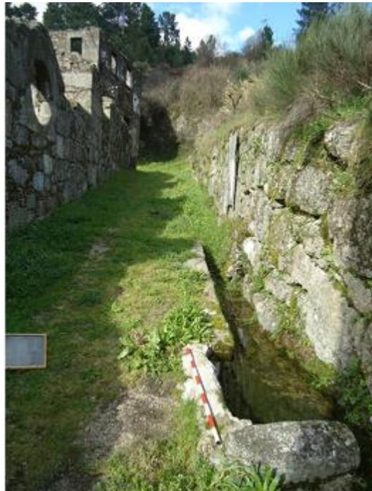
**Figura D:** Levada de água e reservatório de água junto a parede exterior Sul (fotografia de Rodrigo Dias. 6/1/2021).
