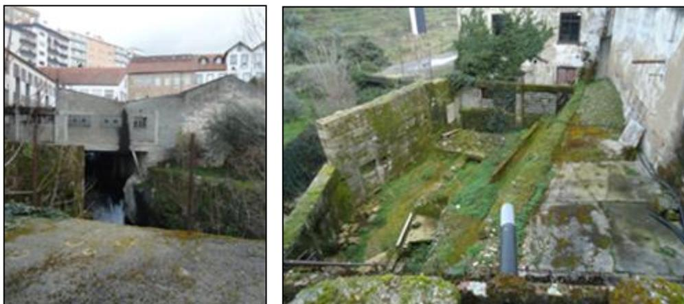
**Figura 27:** À esquerda é possível ver como o complexo industrial da António Estrela & C.<sup>ª</sup> (MED (34)) aproveitou a morfologia da ribeira da Carpinteira e as grandes quedas de água para se implantar junto a ribeira. À direita é possível ver o complexo conservado onde estaria a roda hidráulica (fotografias de Rodrigo Dias. 16/3/2021).
