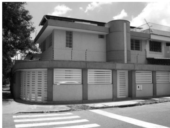
Figura 2 ▶ Moradia em Zona Residencial La California Norte (foto própria, Abril 2009)
