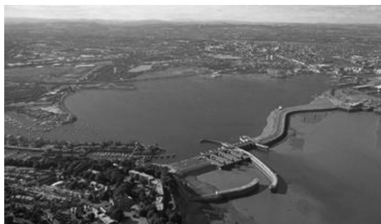
Figura 4 ▶ Barragem da Baía de Cardiff (in Cardiff Harbour Authority)
