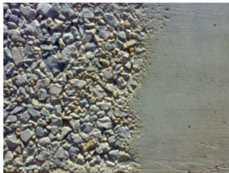
Figura 2-9- Provete com tratamento de jato de areia seca [12]
