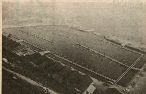
Marina para barcos de recreio na Doca de Santo Amaro, em Lisboa (obra concluída em 1991)
