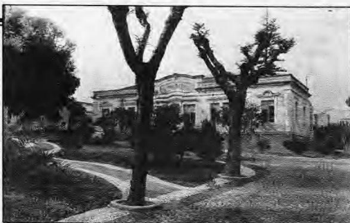
Estação Elevatória de Água dos Barbadinhos: abrirá as portas ao público em simultâneo com a Central Tejo
