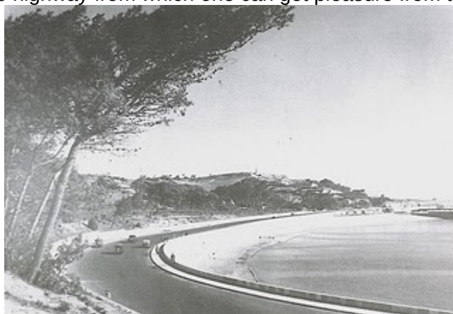
Figure 2: Estrada marginal Lisboa-Cascais 122 (costal road)
