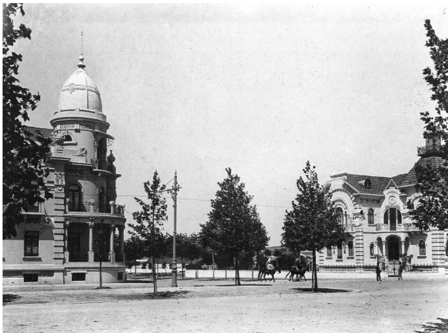
Avenida de Berna, nº85, esquina com a Avenida da República.
