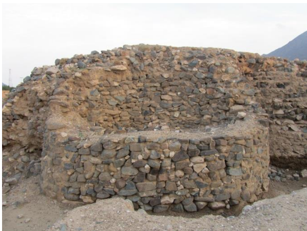
71 - Corfacão – a face do baluarte e vestígios da torre interior. Dez/2012.
