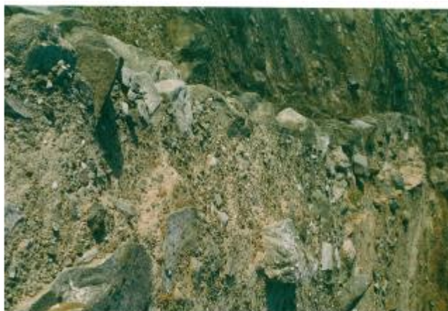
81 - Libédia – o muro de ligação no espaço entre as torres em Abril/2001.
