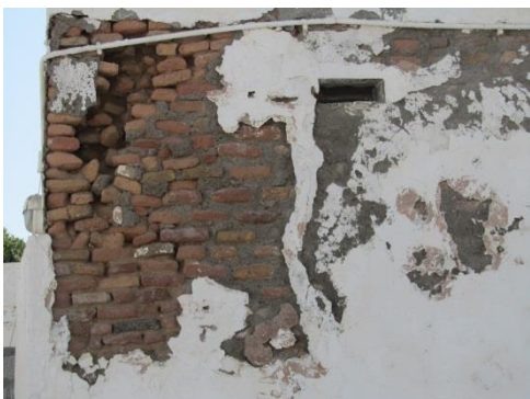
46 - Construção com tijolos na fortaleza de Soar. Dez/2011.
