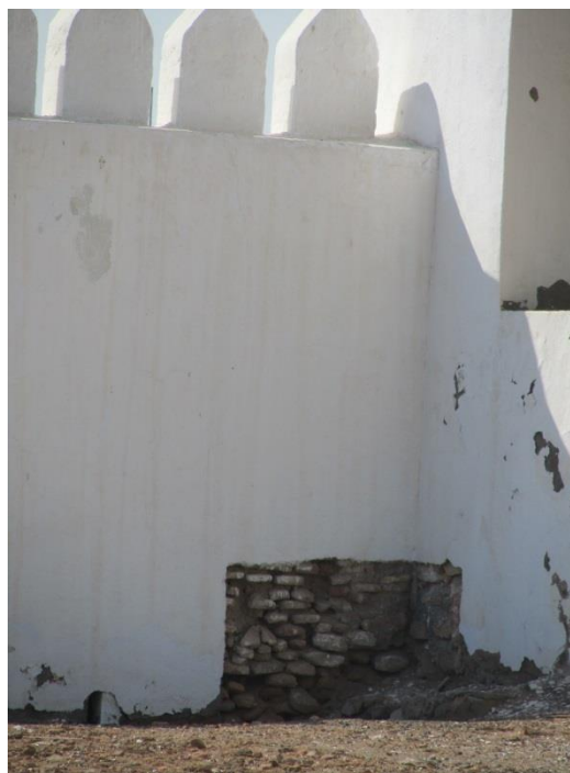
130 - Soar – muro interior observando-se a construção em tijolo. Dez/2011.
