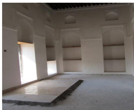
63 - Compartimento interior já "restaurado" Dez/2011.
