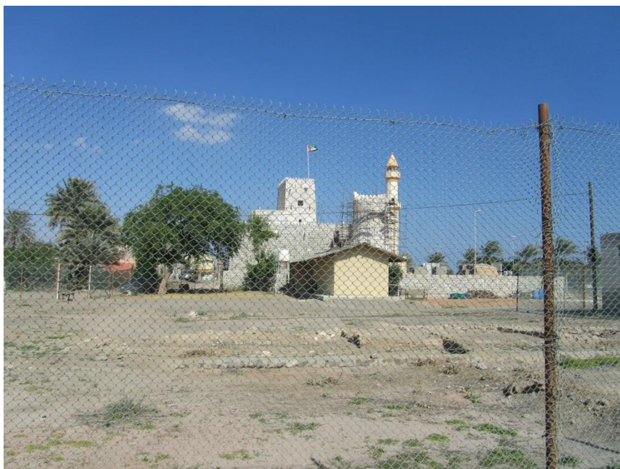
122 - Quelba – escavações junto à face sul. Dez/2012.
