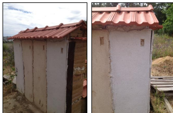
Fig. 2.16 – Argamassas de cal aérea aplicadas em murete de taipa na FCT-UNL
