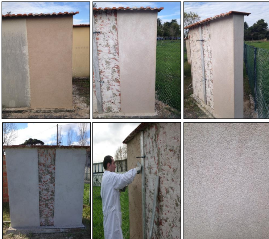
Fig. 3.10 – Detalhe das aplicações dos rebocos nos muretes experimentais
