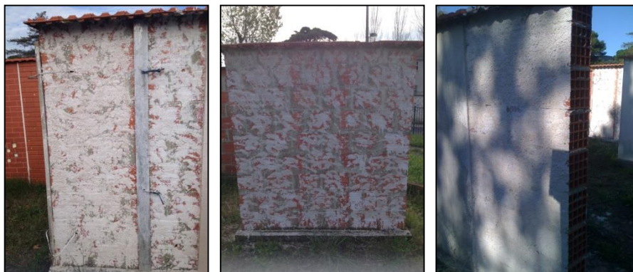
Fig. 3.7- Execução dos salpicos
