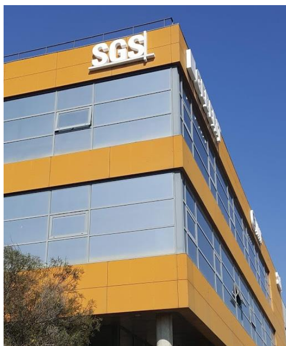
Figura 2.1: Sede local da SGS Portugal em Lisboa.
