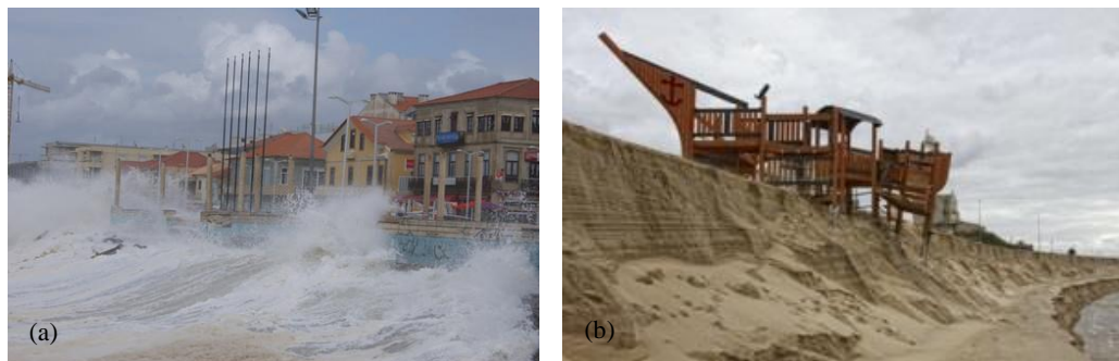
Figura 1.1 – Importância das estruturas de proteção costeira contra o galgamento, Aveiro (a) (fonte: Ondas3.blogs, 2013) e a erosão, Foz do Arelho (b) (fonte: Expresso, 2013)
