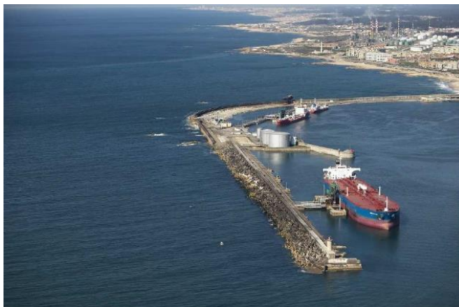
Figura 1.3 – Quebra-mar norte do porto de Leixões (fonte: APDL, 2013)
